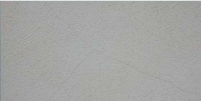
Fissuration de l'enduit minéral (retrait) en raison des conditions de prise et de durcissement ainsi que des caractéristiques de l'enduit.
