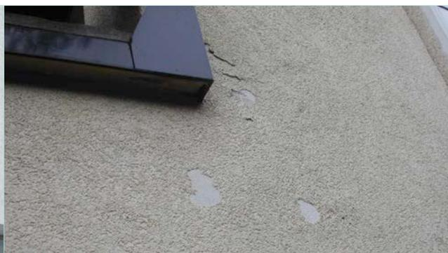
Défaillance du détail au droit du seuil menant à des infiltrations d'eau dans l'enduit, des boursouflures et des décollements.
