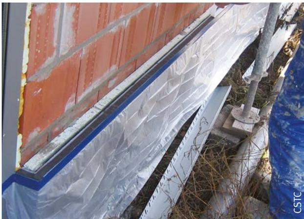
Fig. 95 Pose du préformé d'étanchéité sur la plinthe.
