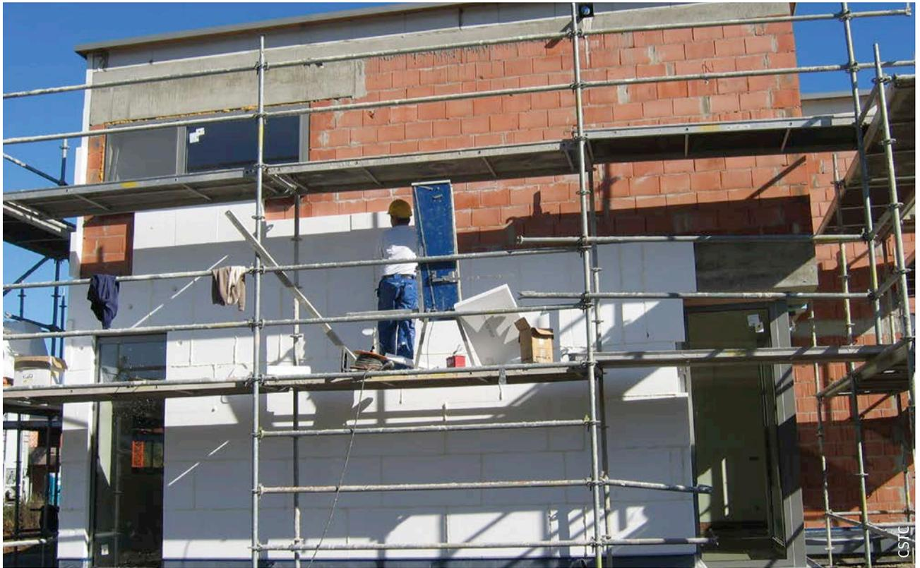
Fig. 13 Pose d'un isolant sur une façade extérieure.
