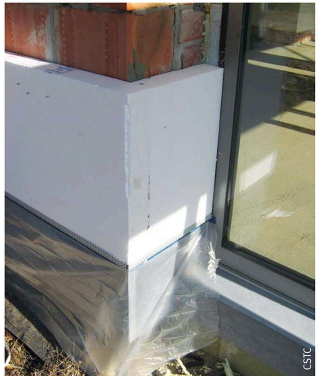
Fig. 112 Pose de l'isolant contre la bande d'étanchéité de manière à la comprimer.
