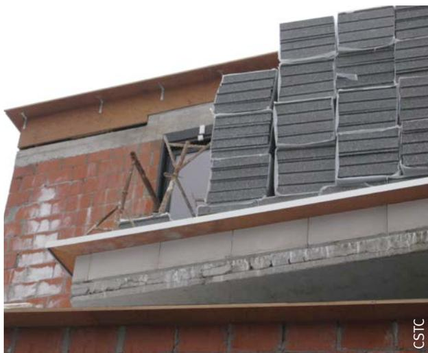
Fig. 66 Raccord aux rives de toitures plates (avant travaux d'ETICS).
