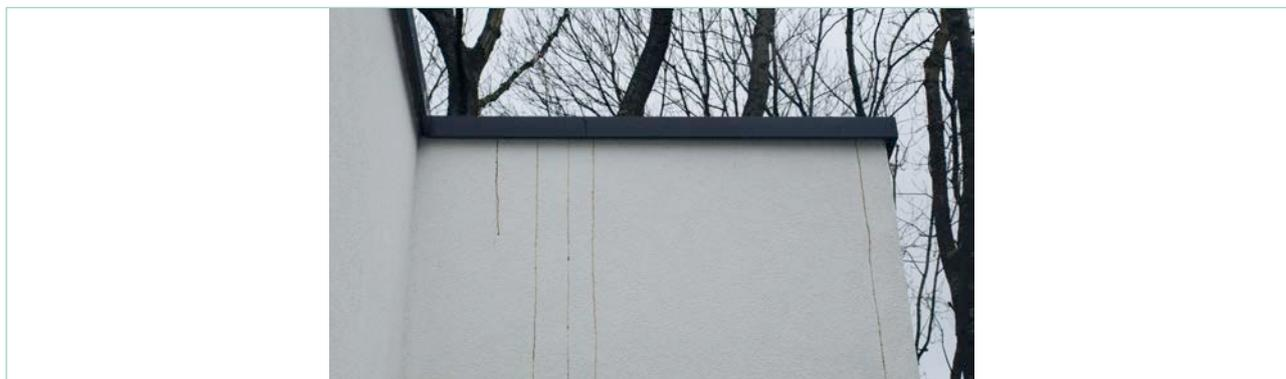
Écoulement d'eau chargée en tanin dû au choix inadapté du couvre-mur et à son humidification.
