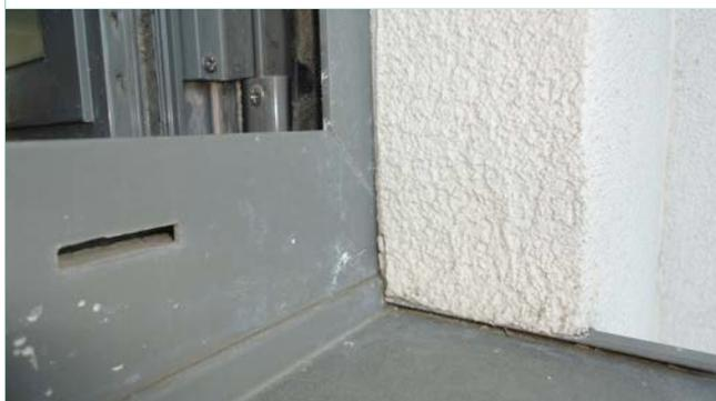
Infiltration d'eau à l'intérieur du bâtiment due à la jonction non étanche entre l'ETICS et la menuiserie.
