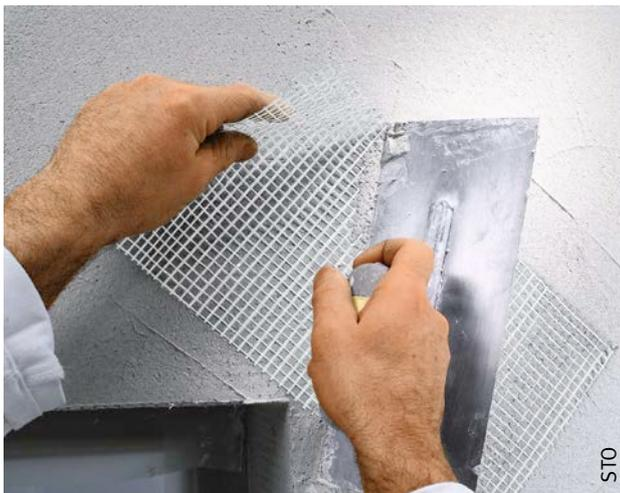
Fig. 127 Pose d'une bande d'armature de renfort dans l'angle d'une baie.
