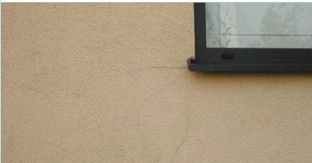
Fissuration de l'enduit à la jonction entre l'enduit et le seuil (l'évolution dépend des caractéristiques de l'enduit et de l'isolant).
