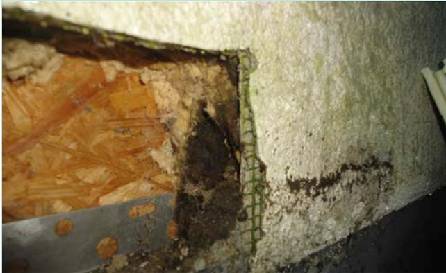
Pourrissement de l'isolant en fibre de bois observé lors du sondage au droit d'une fissure.
