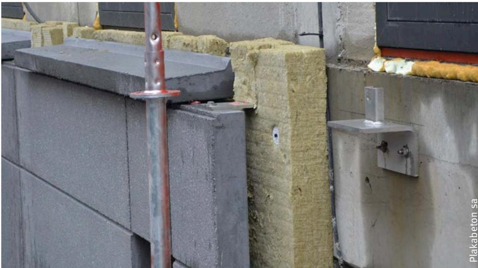
Fig. 84 Exemple de raccord à un mur coulisse.
