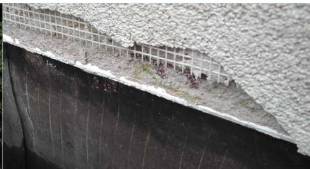
Fissuration et décollement dus à l'armature trop courte qui n'est pas solidarisée au profilé de départ.
