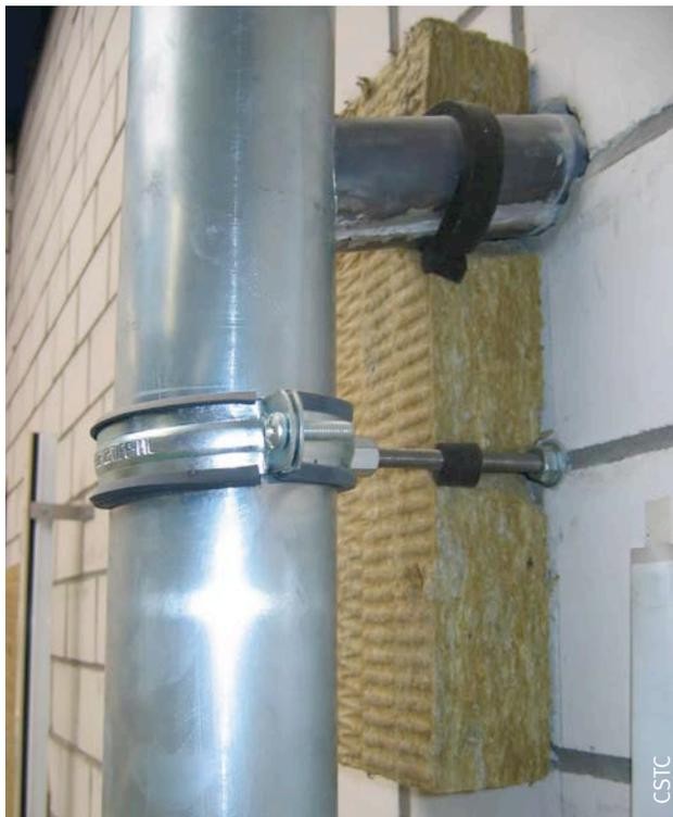
Fig. 111 Pose d'une bande comprimée (fond de joint) à la jonction entre le panneau isolant et le percement de l'ETICS.
