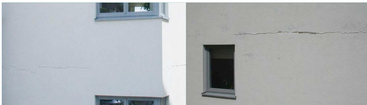
ETICS sur structure en bois (lamellé-cloué) : fissurations qui se manifestent principalement à l'horizontale au droit des nez de plancher, mais également aux angles de baies, et qui sont dues à des déformations de la construction en bois (tassement) ainsi qu'à la présence, dans la structure, d'éléments visant à améliorer le comportement acoustique.
