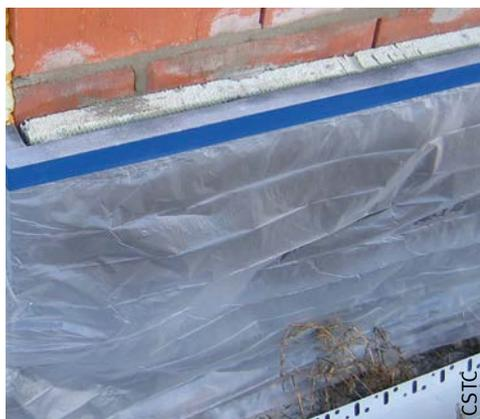
Fig.92 Protection d'une plinthe.
