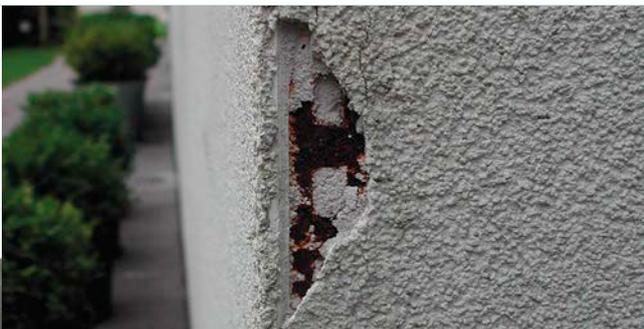
Corrosion d'un profilé d'angle en acier galvanisé.
