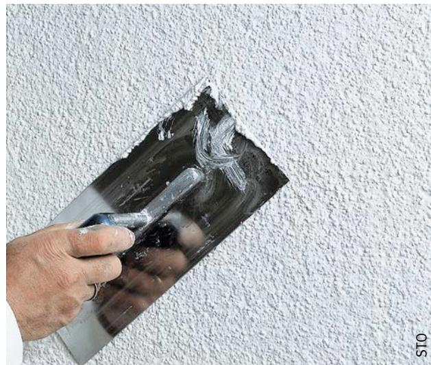
Fig. 136 Grésage d'un enduit de finition mince.
