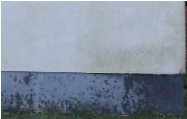
ETICS (isolant en fibre de bois) sur structure à ossature en bois avec panneaux supports d'ETICS. Façade très exposée aux intempéries et dépourvue de mesures de protection spécifiques (absence de débord de toiture, par exemple) et apparition de salissures.
