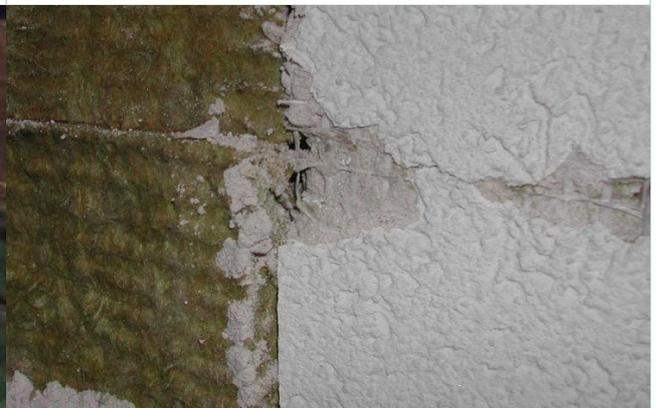
Désaffleurement entre panneaux d'isolation et résistance limitée de l'enduit provoquant la fissuration de ce dernier au droit des jonctions entre panneaux.
