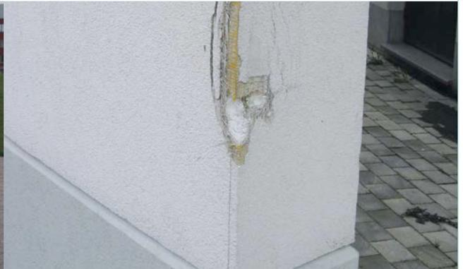
Dégradation mécanique d'un ETICS dans une zone d'accès destinée aux camions.
