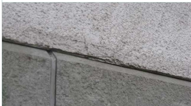
Fissure verticale partant de la jonction entre des profilés et larmier inefficace (l'évolution dépendra des caractéristiques de l'enduit et de l'isolant).
