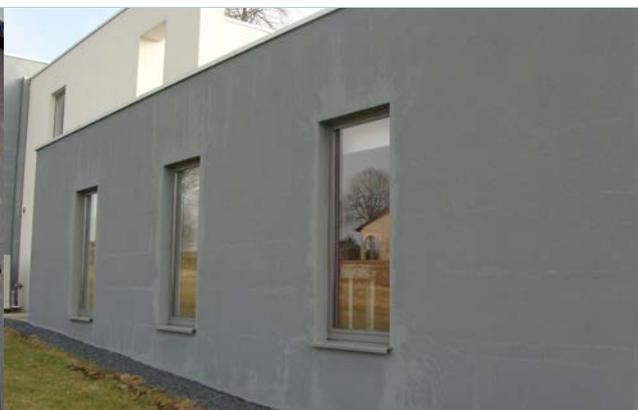
Processus d'humidification et de séchage de l'enduit différents à certains endroits résultant du non-respect des épaisseurs de contact minimales à la jonction entre l'ETICS et les menuiseries.
