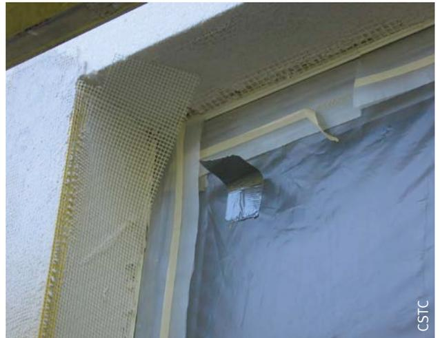
Fig. 125 Pose d'un profilé avec une découpe de ce dernier et du treillis soudé permettant d'assurer la continuité de l'armature au droit de l'angle rentrant.
