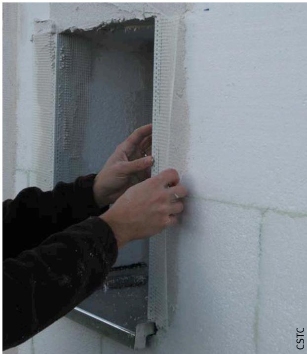
Fig. 124 Pose d'un profilé d'angle.
