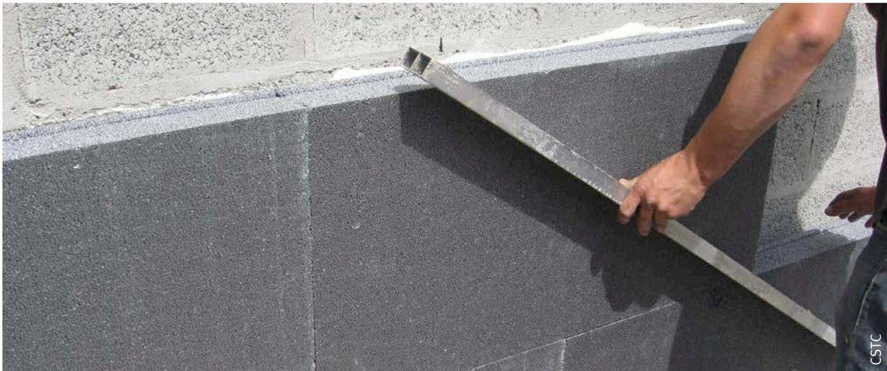
Fig. 2 Mise en œuvre des panneaux d'un ETICS.
