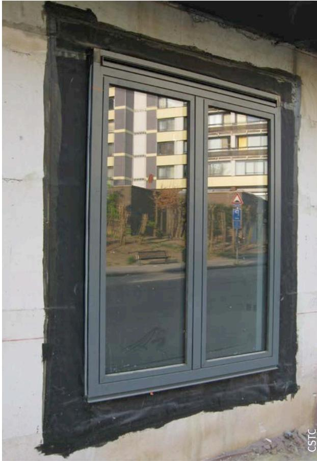
Fig. 56 Écran à l'air entre une menuiserie et le mur.
