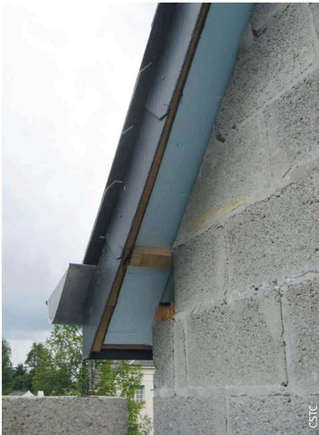
Fig. 74 Raccord à la rive latérale d'une toiture à versants (vue de l'isolant interposé avant les travaux de façade).
