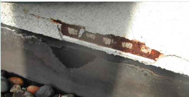
Corrosion d'un profilé de départ (inadapté, car dépourvu de larmier) en acier galvanisé.
