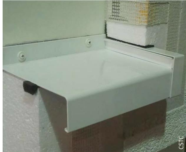
Fig. 108 Pose d'une bande d'étanchéité comprimée sur le pourtour des seuils (maquette de démonstration; châssis et son rejet d'eau non représentés).
