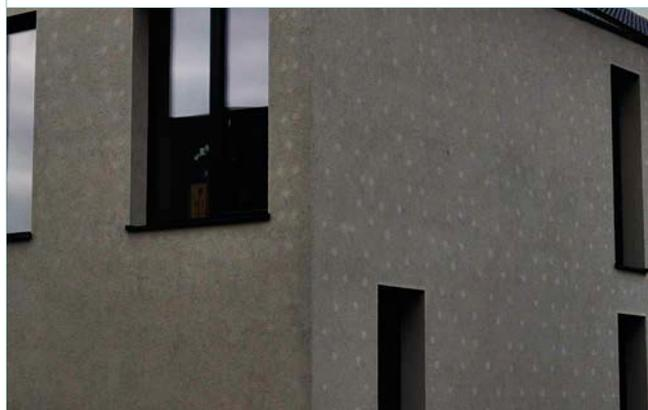
Apparition de la trame des fixations à la surface de l'enduit liée à un pont thermique et aux caractéristiques hydriques de l'enduit.
