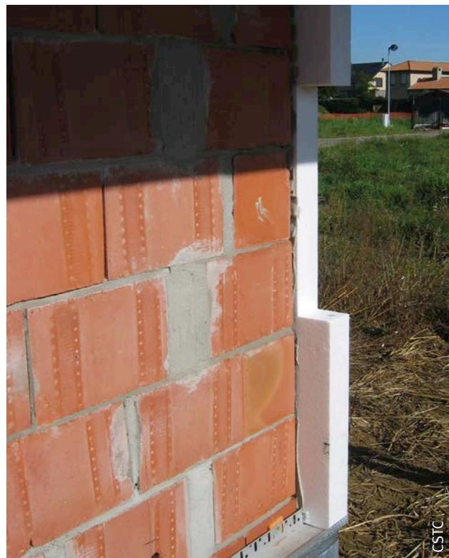
Fig. 103 Harpage dans les angles du bâtiment.
