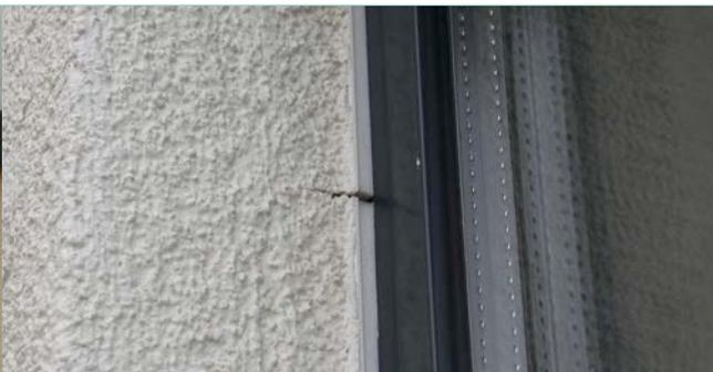
Fissuration de l'enduit à la jonction entre des profilés (l'évolution dépend des caractéristiques de l'enduit et de l'isolant).
