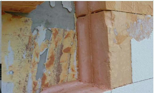
Apparition de la trame des joints entre panneaux d'isolation en surface de l'ETICS révélant l'instabilité dimensionnelle de l'isolant.
