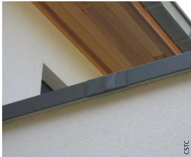
Fig. 67 Raccord à la rive d'une toiture plate.
