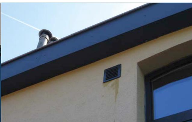
Écoulement du condensat issu d'une ventilation des égouts sanitaires en surface de l'enduit (absence de rejet d'eau).
