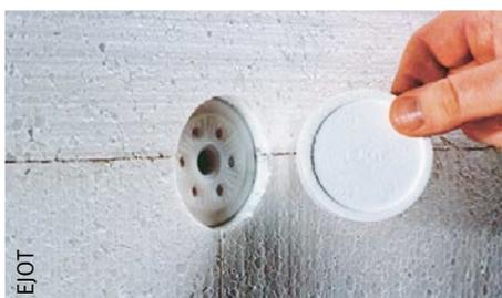
Fig. 116 Pose d'une fixation au cœur de l'isolant.
