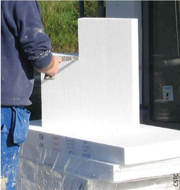
Fig.107 Découpe adaptée préalable à la pose du panneau dans un angle de baie.
