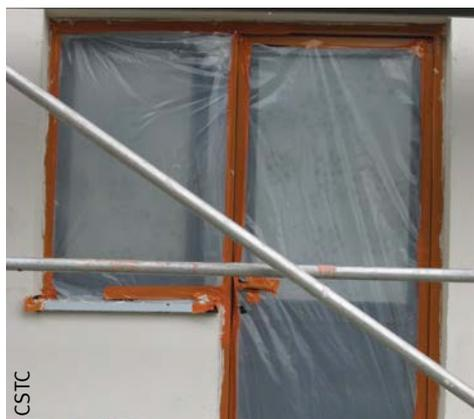
Fig. 93 Protection d'une fenêtre et d'une porte.
