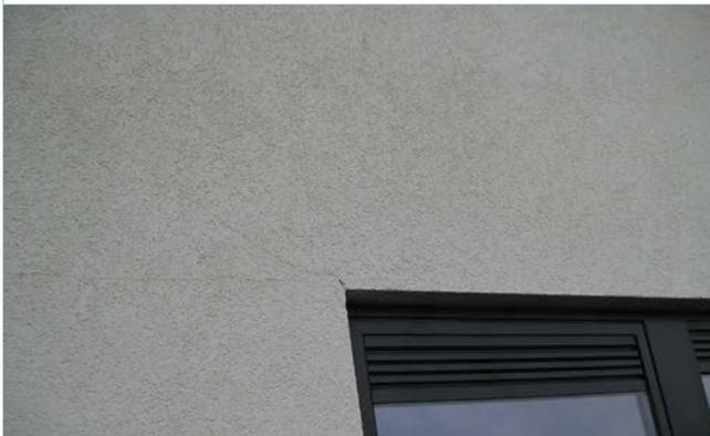
Fissuration de l'enduit aux angles de baie due à l'assemblage de plusieurs morceaux d'isolant et/ou à l'absence de renfort.
