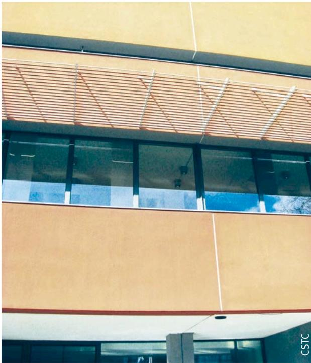
Fig. 87 Joints de mouvement à la surface d'un ETICS.
