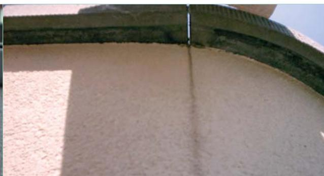
Écoulement et salissure en raison de la dégradation du mortier de joint.
