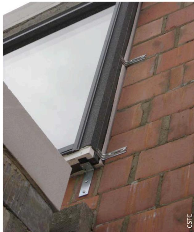
Fig. 55 Pose de la partie fixe du châssis dans l'alignement de la couche d'isolation de la façade (pose excentrée ou en applique).
