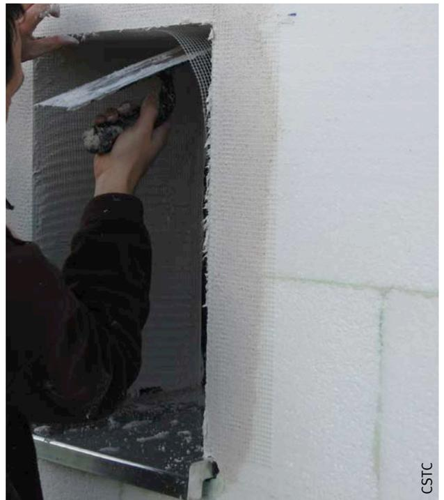
Fig. 126 Pose d'une armature de renfort pour assurer la continuité de l'armature dans l'angle rentrant.
