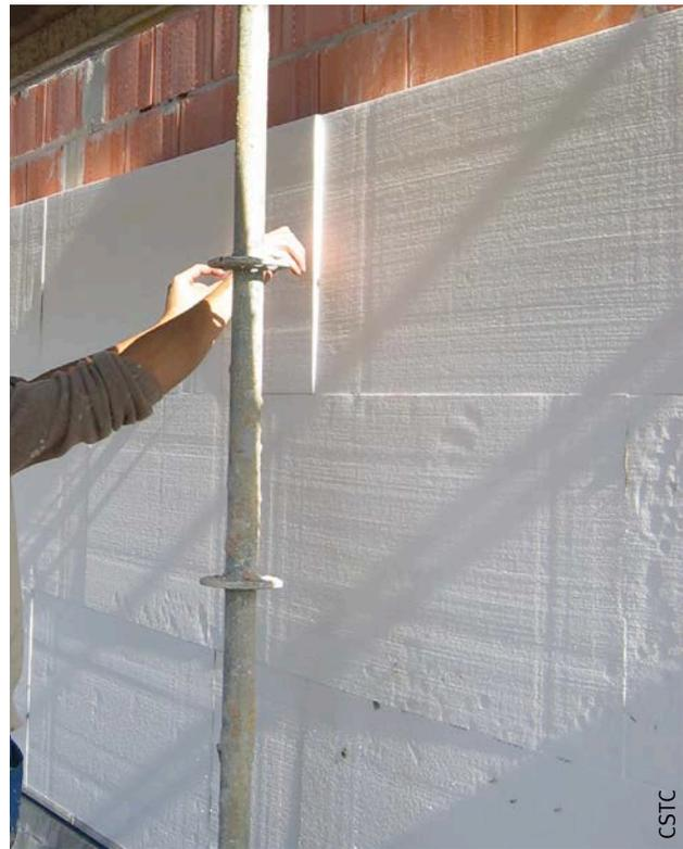
Fig. 101 Pose des panneaux à joints verticaux alternés.
