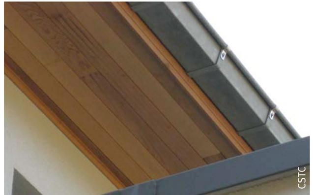
Fig. 73 Raccord entre un ETICS et la rive d'une toiture à versants.
